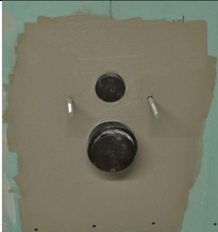
4d. Etter 2,5 timer smøres et tredje lag fullstendig rundt både spyle- og avløpsrøret.
