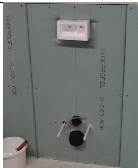
2. Frontplaten, hvor hullene på forhånd er skåret ut, monteres – se påfølgende bilder.
