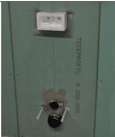
4. Påfør smøremembran på de aktuelle stedene.
