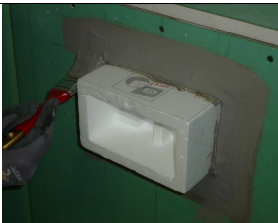
5c. Påfør omgående lag 2 etter at flensen er strøket på plass og glatt ut.
