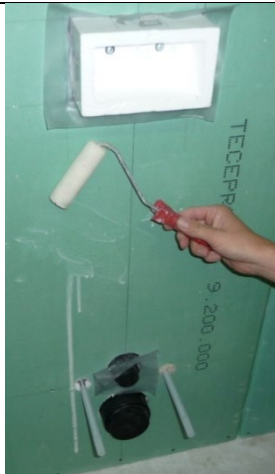
3. Påfør primer på frontplaten
